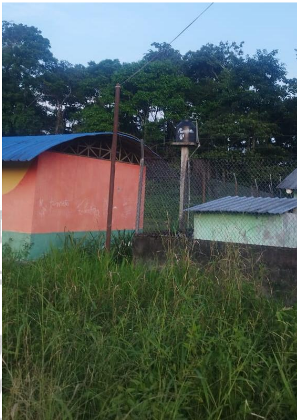
Colocación de poste metálico para izado de cable
