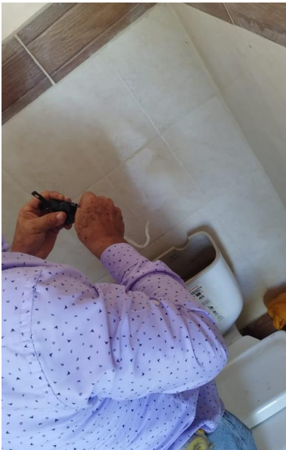
Suministro e instalación de flapper en baños
