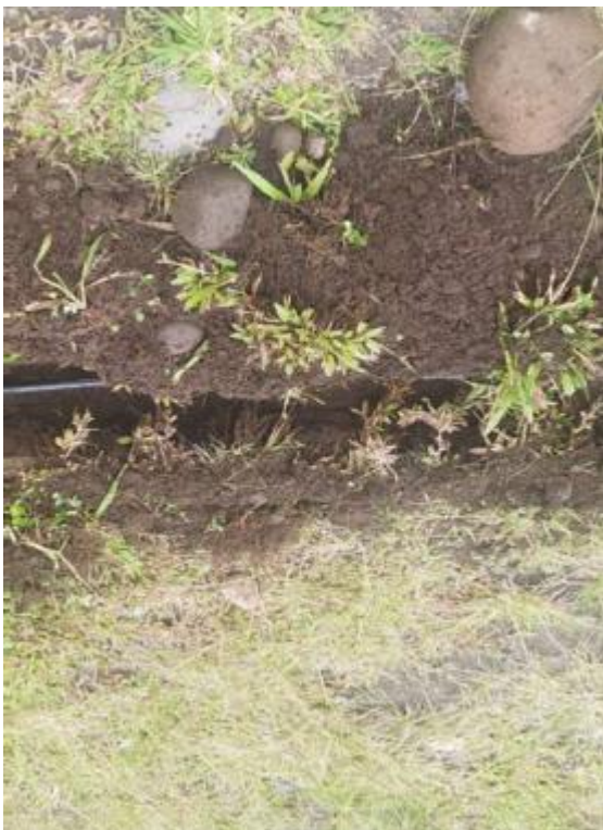
RELLENO COMPACTADO (MATERIAL DE SITIO)
