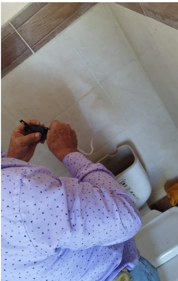
Suministro e instalación de flapper en baños
