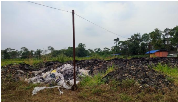
Instalación acometida conductor de cobre thh 2x10 awg
