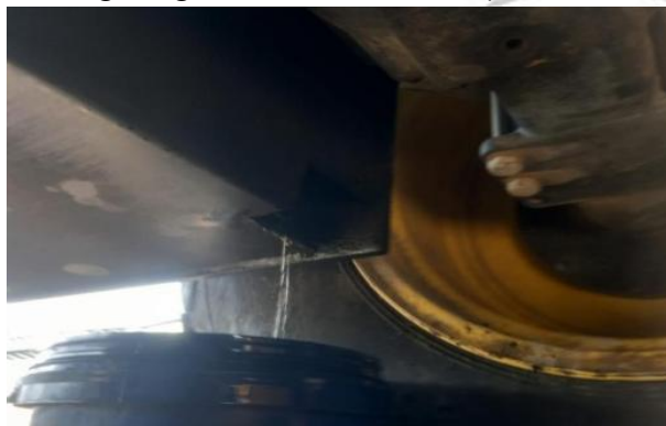
Corregir fuga de aceite del neplo de salida del tanque hidráulico
