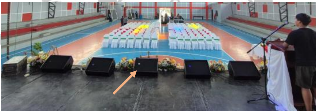
Sistema de Monitoreo 4 monitores de piso 12"
