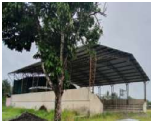
Fotografía 2-63: Coliseo deportivo /Barrio Palma Oriente/ Foto: Recorrido en campo PDOT 2020
