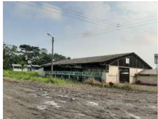
Fotografía 2-53: Coliseo deportivo /Comunidad Juataracu / Foto: Recorrido en campo PDOT 2020
