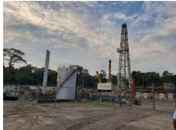
Fotografía 2-34: Plataforma petrolera / Foto: Recorrido en campo PDOT
