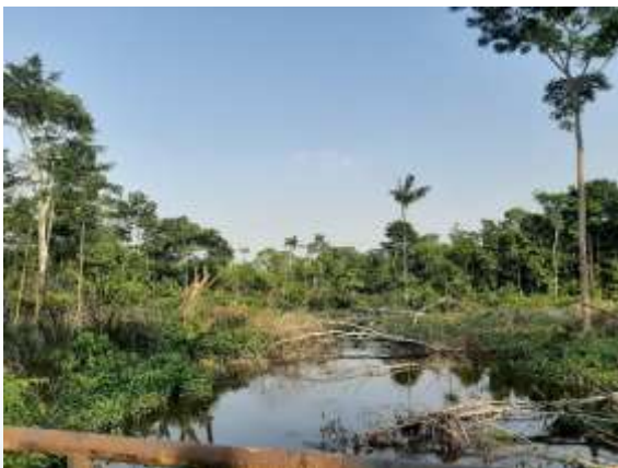
Fotografía 2-84: Estado de puente de tubería reciclada/ Foto: Recorrido en campo PDOT 2020
