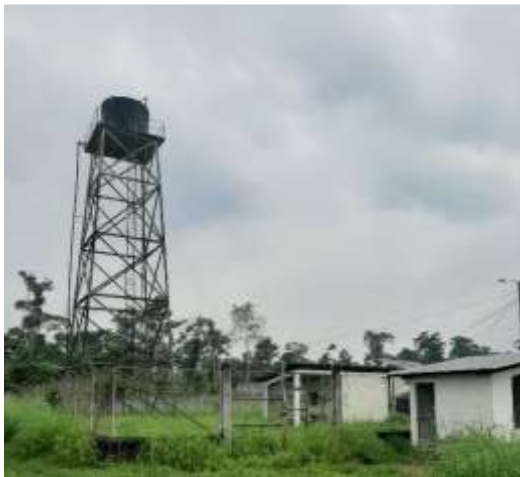
Fotografía 2-74: Tanque elevado de agua /San Pablo / Foto: Recorrido en campo PDOT 2020
