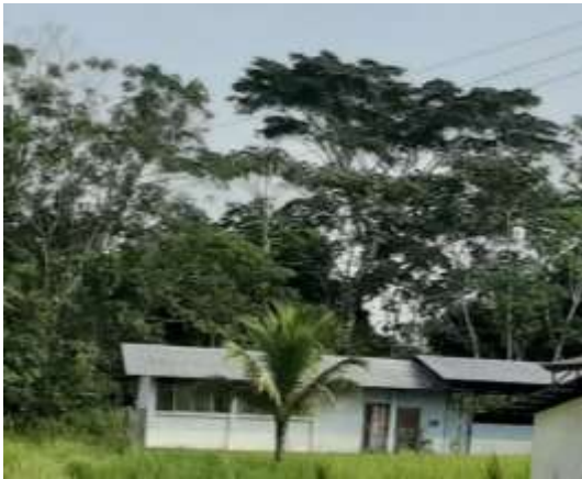
Fotografía 2-56: Casa Comunal /Comunidad Huataracu/ Foto: Recorrido en campo PDOT 2020
