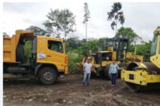
Fotografía 2-83: Mantenimiento vial Foto: Recorrido en campo PDOT 2020
