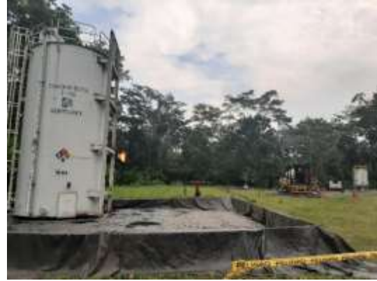
Fotografía 2-33: Plataforma petrolera / Foto: Recorrido en campo PDOT
