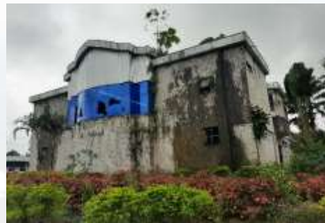
Fotografía 2-69: Centro comercial en desuso /Parque Central/ Foto: Recorrido en campo PDOT 2020
