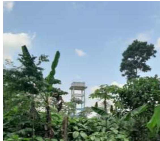
Fotografía 2-76: Tanque elevado de agua /Comunidad Toyuca/ Foto: Recorrido en campo PDOT 2020
