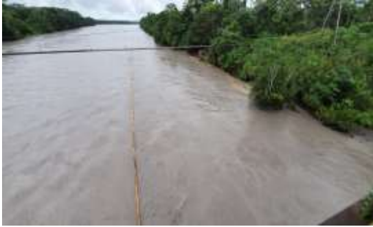
Fotografía 2-5 : Barreras de contención sobre el río Coca/ Puente San Sebastián/Foto: Recorrido en campo PDOT
