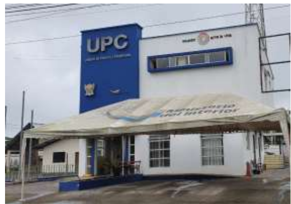
Fotografía 2-71: Centro comercial en desuso /Parque Central/ Foto: Recorrido en campo PDOT 2020
