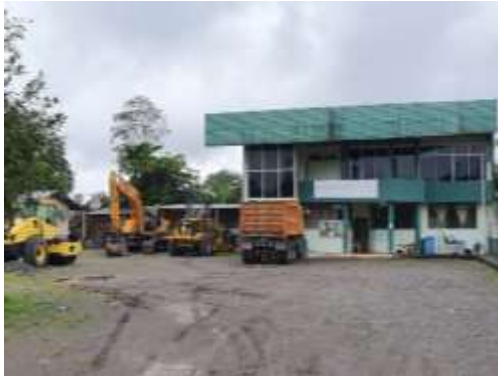
Fotografía 2-70: Centro comercial en desuso /Parque Central/ Foto: Recorrido en campo PDOT 2020
