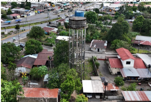
Fotografía: Tanque elevado de agua.
