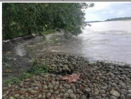
REGISTRO FOTOGRÁFICO: Muro de gaviones deteriorado
